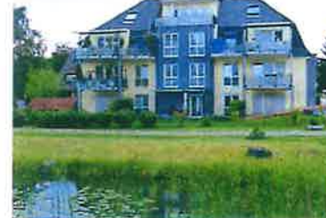
SATTELWEG BAD DÜRRHEIM WEG-Verwaltung mit 8 Wohnungen und Tiefgaragenstellplätzen
