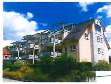
GARTENSTR. 1 BAD DÜRRHEIM WEG-Verwaltung mit 11 Wohnungen und Tiefgaragenplätzen
