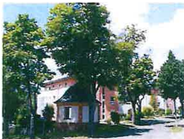
SONNENSTRASSE 2 IN BAD DÜRRHEIM WEG-Verwaltung mit 15 Wohnungen und Tiefgaragenstellplätze
